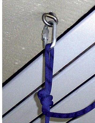
Abb. 137: Schwerlastanker mit Stahlkarabiner
